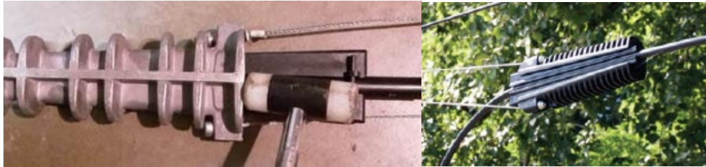
Abbildung 72: Demontage Abspannklemme-Gf – dies gilt auch für Klemmen aus Kunststoff
