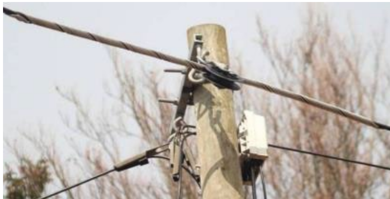
Abbildung 31: Beispiel einer Hängerolle und einer Schwingschutzspirale
