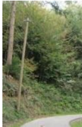
Abbildung 60: Beispiele für nicht zulässigen Schiefstand bei Mast im Winkelpunkt (links) und Tragmast mit zu großer Abweichung (rechts)
