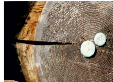
Abbildung 55: Rissbildung am Holzmast (Beispiel zulässig)
