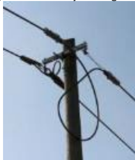
Abbildung 27: Doppelabspannung mit Akl-Gf
