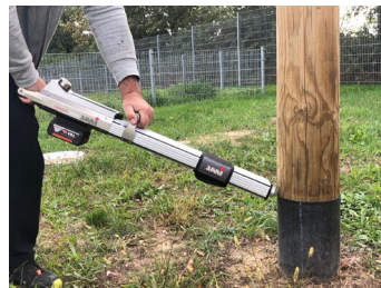
Abbildung 65: Messung an Masten mit PermadurT-System
