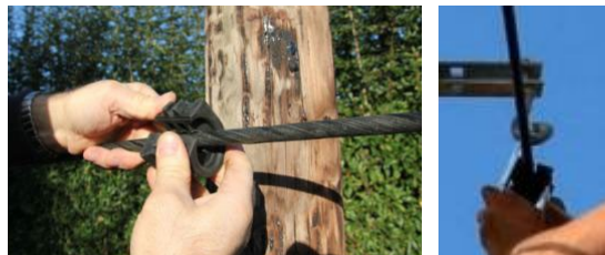
Abbildung 36: Kabelbefestigung Häkl
