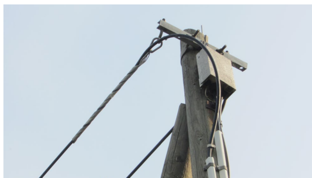
Abbildung 32: Beispiel einer Abspannspirale
