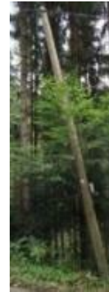
Abbildung 60: Beispiele für nicht zulässigen Schiefstand bei Mast im Winkelpunkt (links) und Tragmast mit zu großer Abweichung (rechts)
