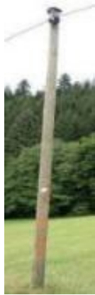
Abbildung 59: Beispiel für zulässigen Schiefstand von Masten
