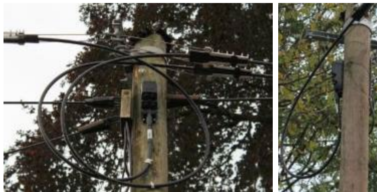
Abbildung 47: Gf-MastBox mit 8-Ports und vorkonfektionierten Hauszuführungskabeln
