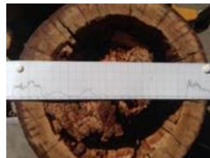
Abbildung 3: Bohrprofil-Beispiel für einen Mast mit Fäule/Hohlraum → für Wiedereinsatz nicht geeignet
